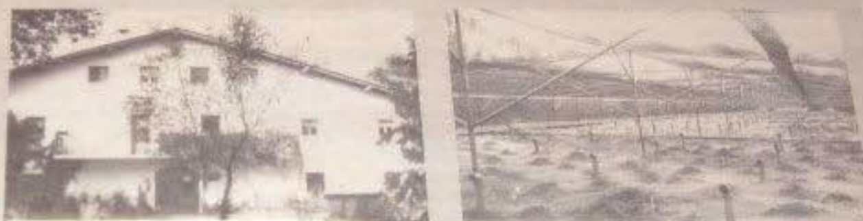
Fachada de la Quesería Dorrea y ejemplo de la tecnología BIDA utilizada por una industria vinícola de Chile
